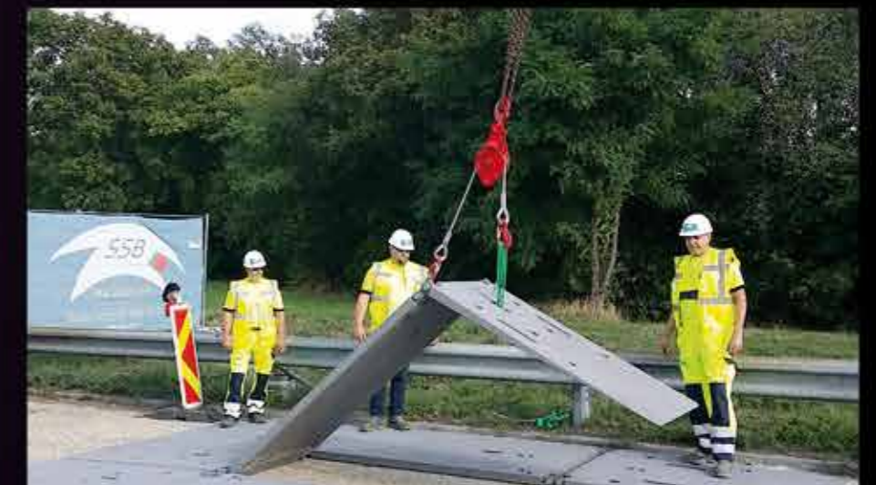
Prüfende Blicke beim Funktionstest eines MMBS-Elements.
