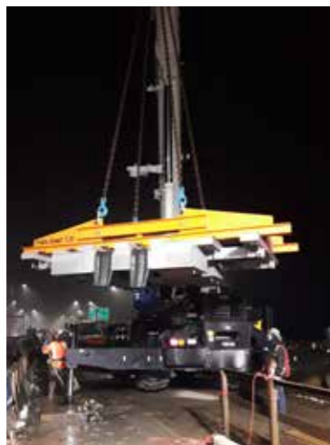
Für das schnelle und exakte Aufsetzen der Wanderschwellen werden vor der Installation pro Dehnfuge sechs Montagefüße in die Bauwerkskonstruktion eingemessen und fixiert. Dieses Vorgehen spart Einsatzzeit von schwerem Hebegerät.
