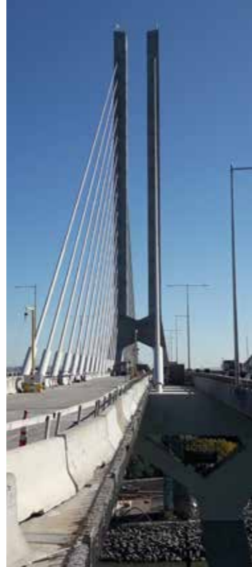
Eingebaut wurden die 16 Wanderschwellen von November 2020 bis April 2021.
